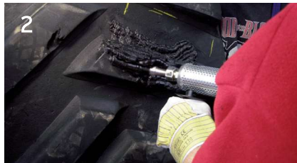
Schadenstrichter für Heizvorgang vorbereiten
